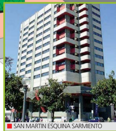
SAN MARTIN ESQUINA SARMIENTO
